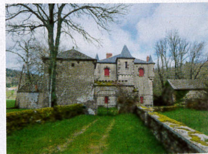
Le château de Labrot, à Luc, date du XII e siècle. Il a été en partie restauré.
